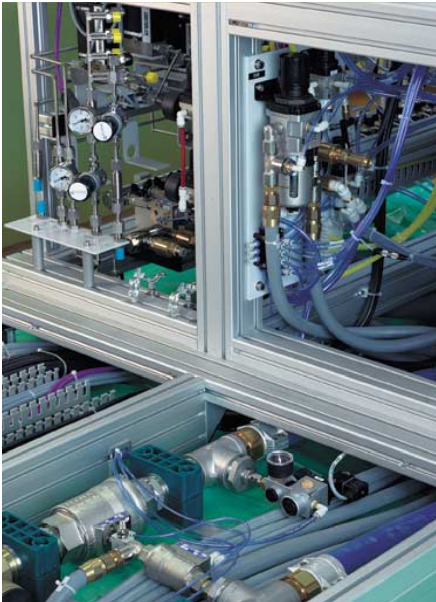
Integration der Baugruppe Wasserbatterie in die Unterkonstruktion.
